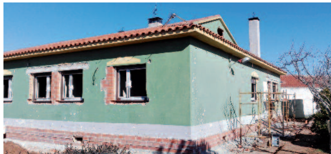
Una de las viviendas que se está rehabilitando
